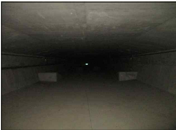
거더 내부 전경
