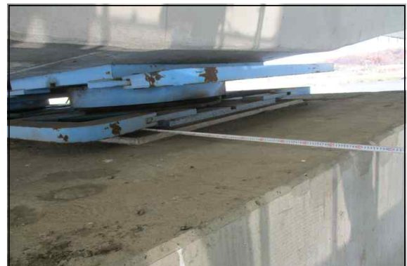
교량받침 연단거리 측정 현황②
