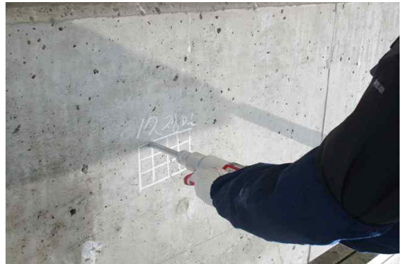
교각 압축강도 측정
