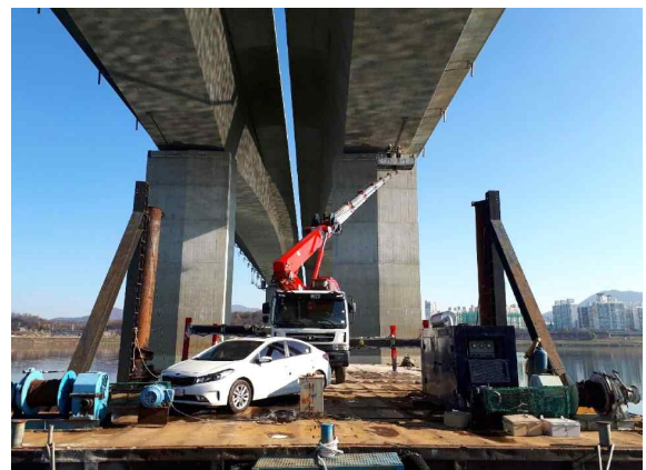
바지선 및 작업차량을 이용한 외관조사
