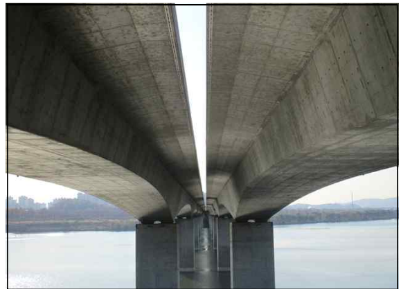
거더 외부 전경
