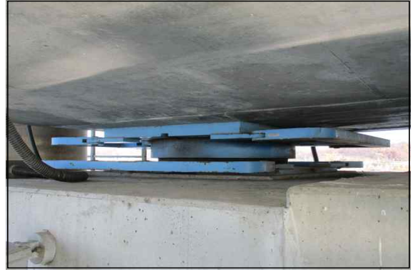
교량받침 전경 (P9 SH1:고정단)
