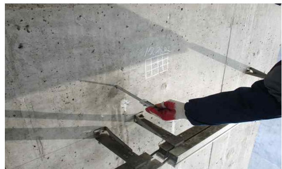
교각 탄산화 시험
