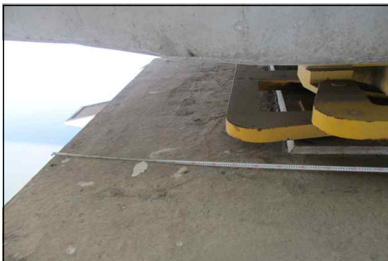
교량받침 연단거리 측정 현황①
