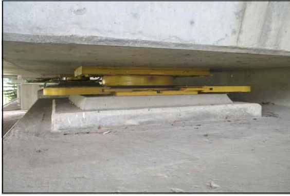
교량받침 전경 (A1 SH1:가동단)
