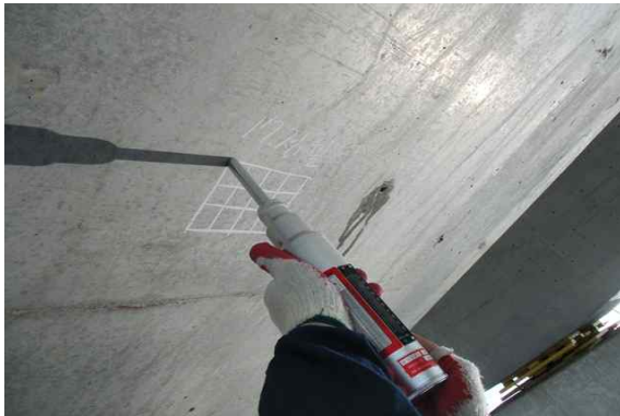
거더외부 압축강도 측정
