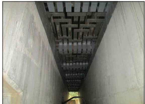
신축이음 하부 전경(A2)
