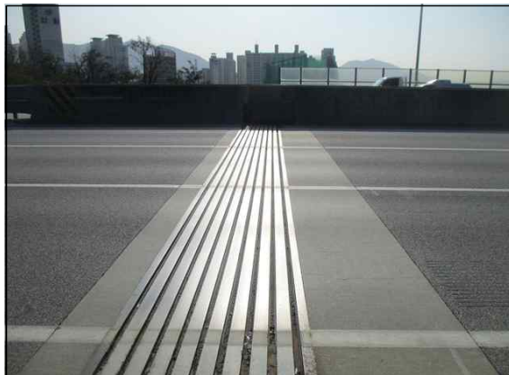
신축이음 상부 전경(A2)
