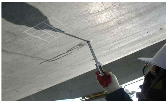
거더외부 탄산화 시험
